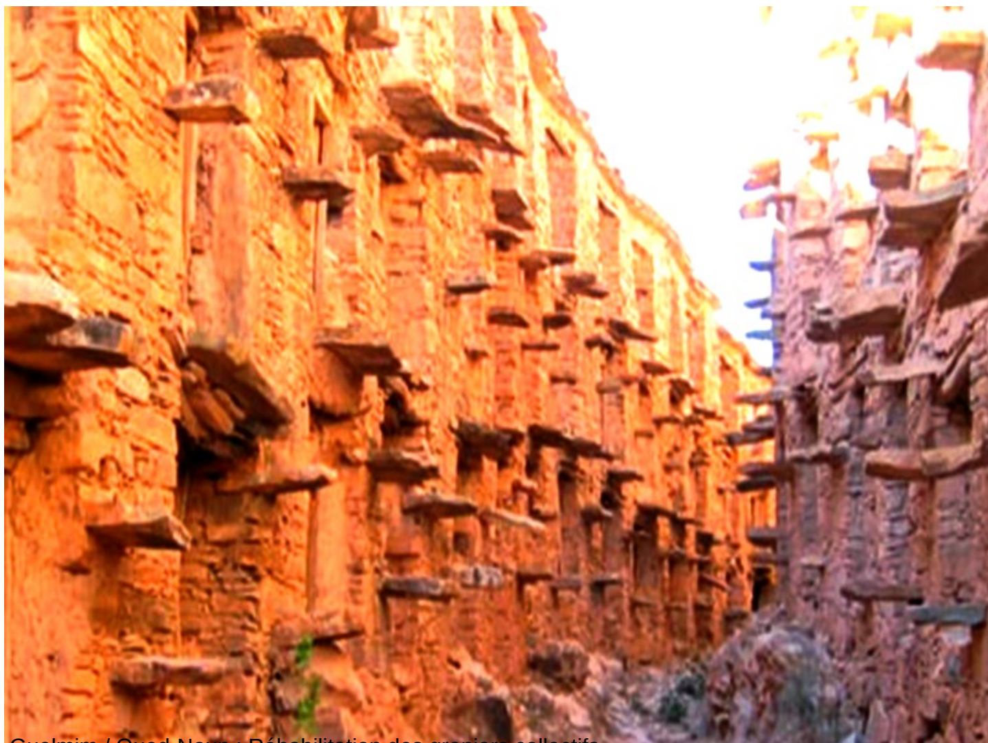
Guelmim / Oued-Noun : Réhabilitation des greniers collectifs
